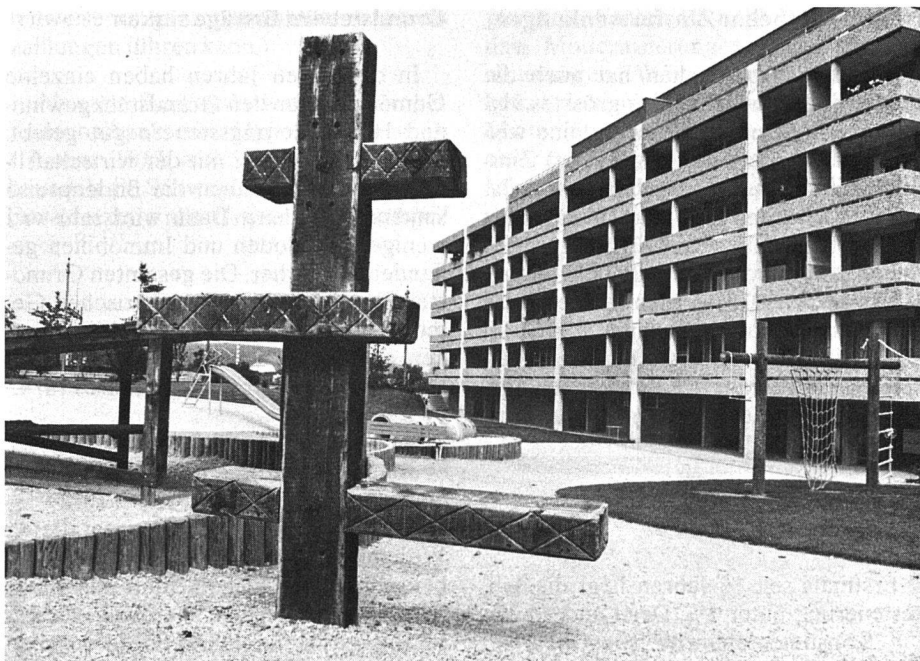
Kletterbaum auf der Spielanlage der Siedlung Bodenacker in Dulliken (Photos Thomas Ledergerber, Olten)
