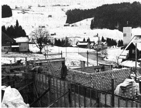
Die Baustelle im Winter 76/77
