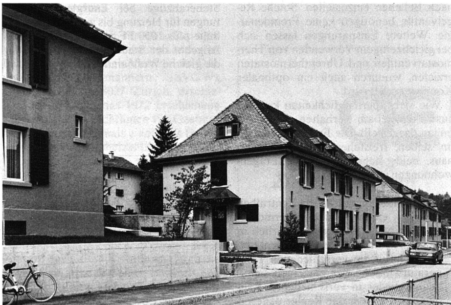
Teilansicht der Überbauung Breiteli. Zwischen dem vordersten und dem mittleren Block befindet sich – unterirdisch – die neue Gas-Heizzentrale.
