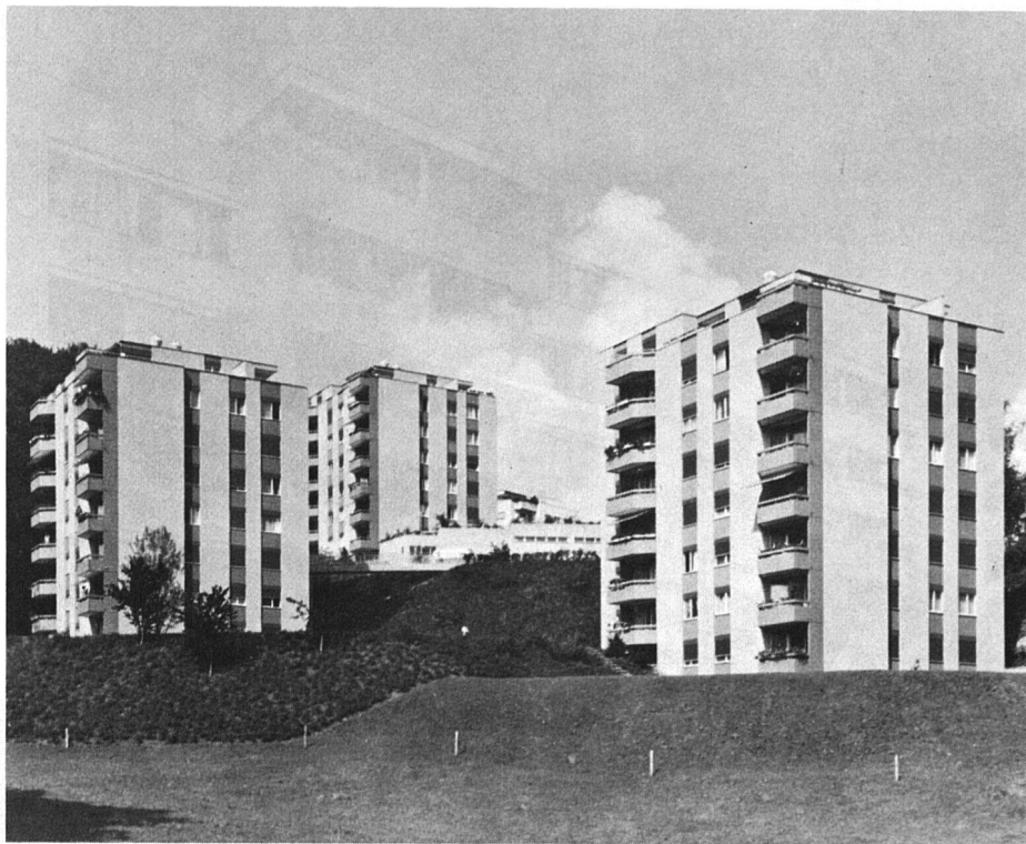
Wohnsiedlung Studhalden 5, Baujahr 1974
