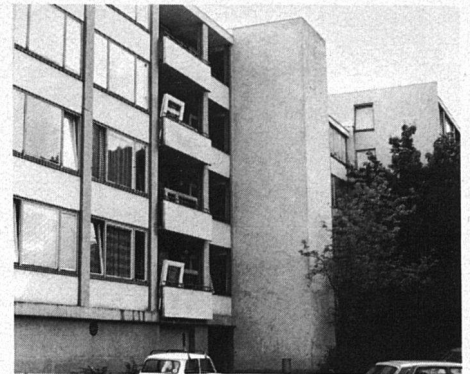
Fassadenansicht vor der Erneuerung
