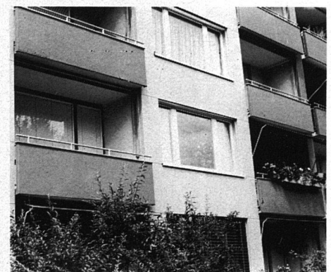
Fassadendetail nach der Sanierung
