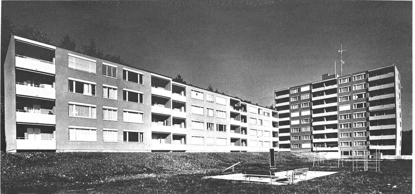
Siedlung «Grafenbuck» der Immobilien- genossenschaft Schaffhausen, Baujahr 1973/74. 58 Wohnungen, Kinderspiel- platz und Autoeinstellhalle.
