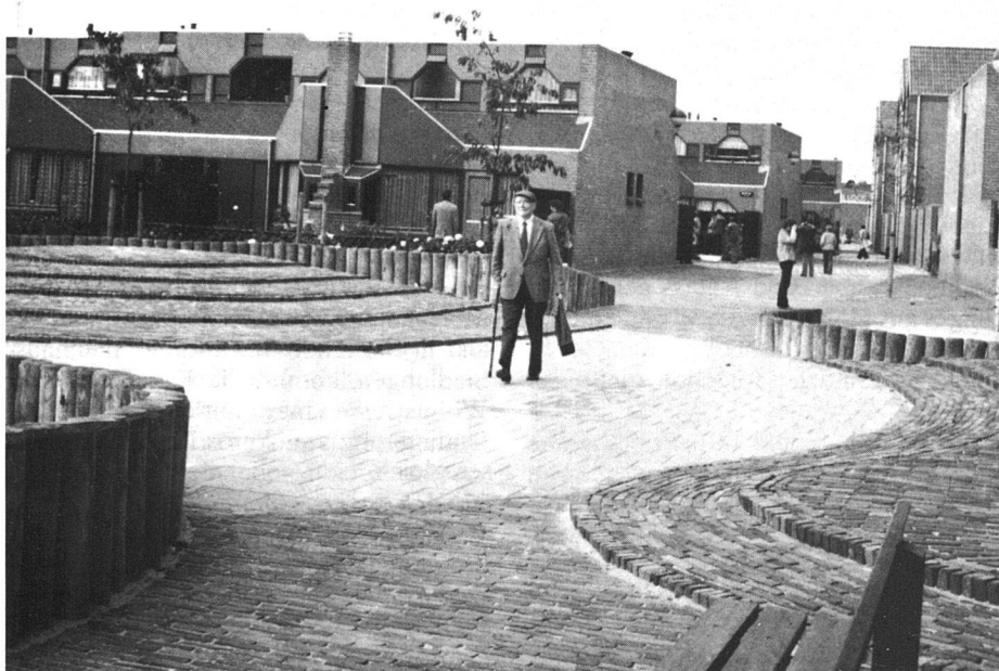
Zwischen den Reihen-Einfamilienhäusern finden sich Freiräume für Spiel, Erholung und Kontakte. Die Parkplätze sind am Rande der Siedlung angebracht.
