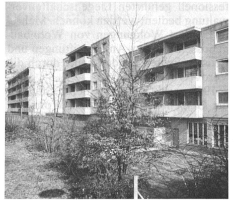
Die Bauten der 3. und 4. Etappe der BSG Buenz Wohlen mit dem Kindergartenareal.
