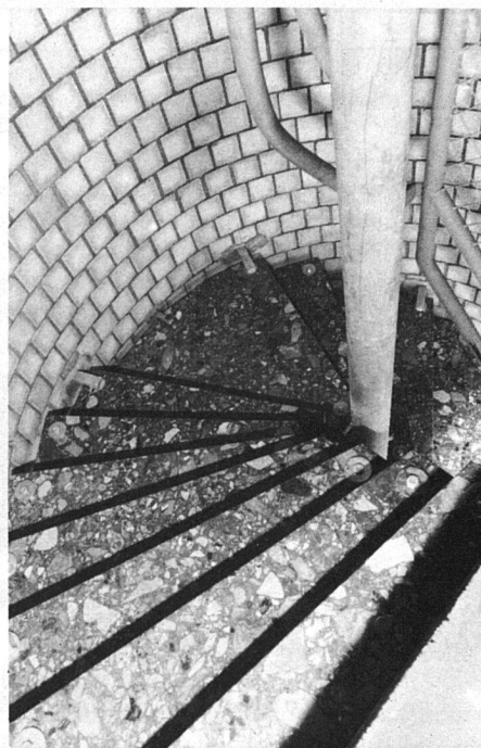
Das neue Treppenhaus: Wände Kalksandstein, Stufen Kunststein.
