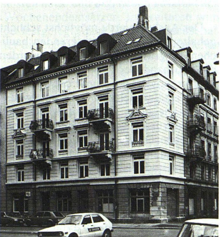
Von oben: Fassade vor der Renovation. Photo: M. Rüegg-Reinhardt
