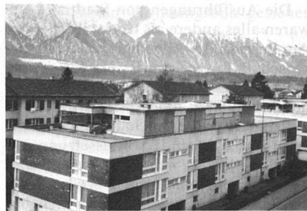
Sanierte Flachdächer an der Hallerstrasse in Thun.
