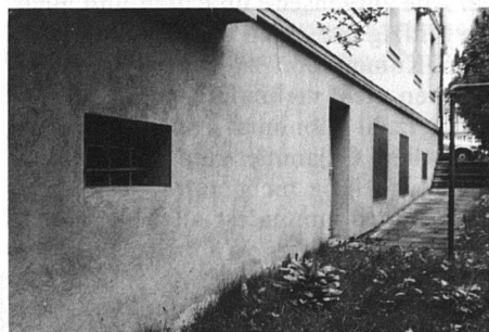
25 Jahre nach Mauerentfeuchtung
