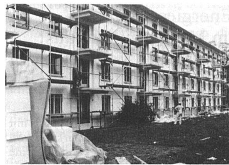
Starre Isolation während des Aufbaus (Baugenossenschaft Schönauf)
