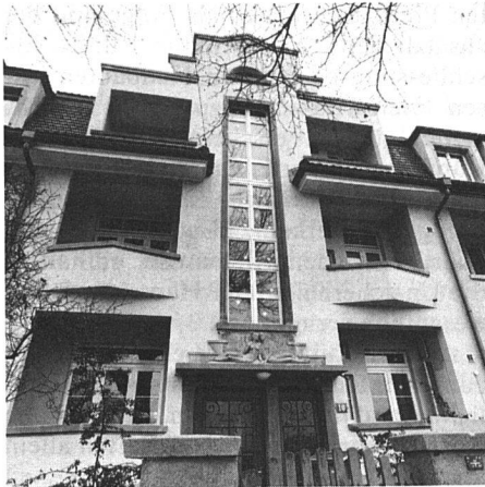
Ein sinn- und stilvoll renoviertes Wohnhaus an der Irchelstrasse in Zürich-Oberstrass. Die ursprüngliche Farbgebung wurde innen und aussen wiederhergestellt, und die positiven Stilmerkmale im und am Gebäude wurden belassen.
