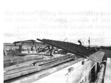
Zimmerleute an der Arbeit
