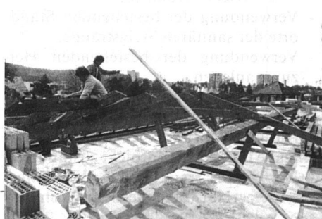
Isoliertes Geschoss, während der Demonstgung des Dachstockes
