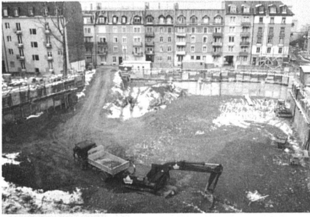
Die imposante Baugrube im März 1982
