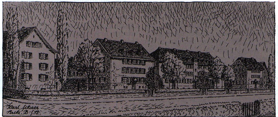
Allg. Baugenossenschaft Zürich, Bauten südlich der Weststrasse im Verlikon.
