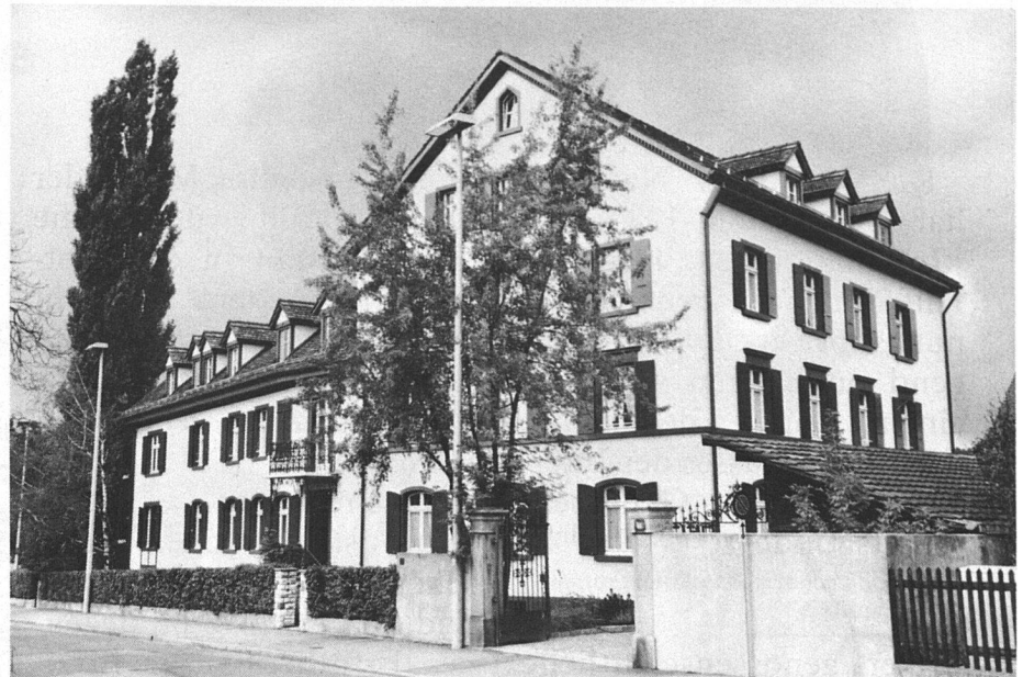
Das charaktervolle Hauptgebäude nach der geglückten Sanierung
