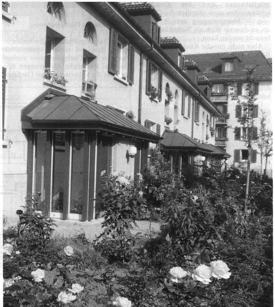
Unten: Angebaute Windfänge schaffen eine interessante Pufferzone zwischen innen und aussen. Foto: Karin R. Lischner
