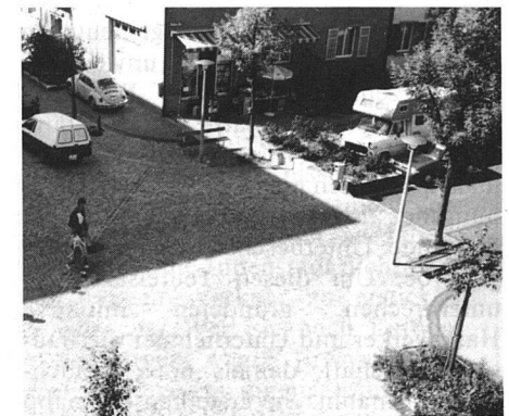
Aufpflasterung der Kreuzungen und Möblierung mit Bänken.
