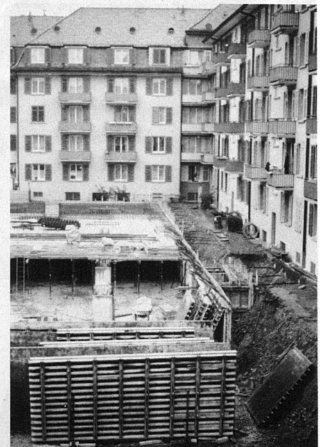
Unterniveaugarage (Gertrudhof) im Bau. Foto: Heinz Rüedi
