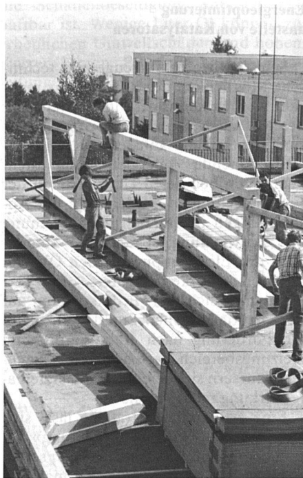
Zimmerleute beim Aufrichten von Stützen und Balken
