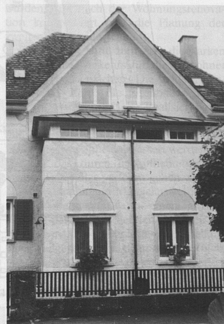
Doppel­einfamilienhäuser: Nach Badeinbau und beträchtlicher Vergrösserung der Eingangspartie.
