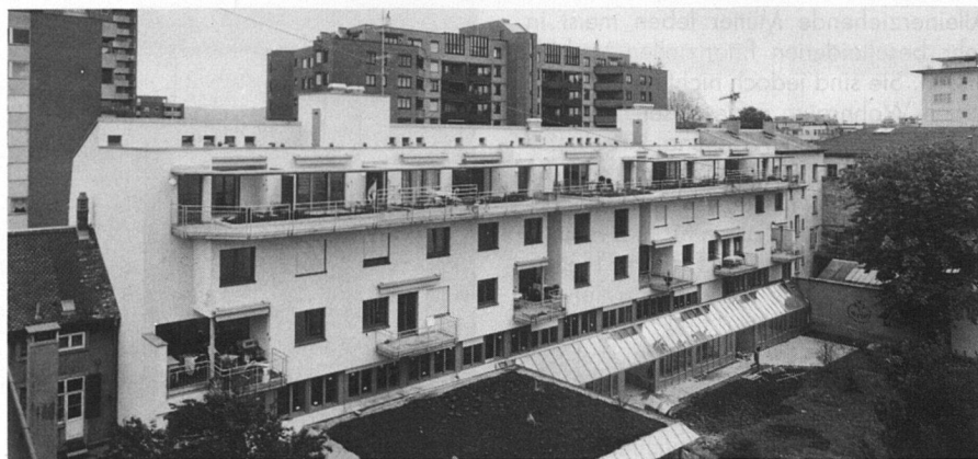
Neubau mit 15 Wohnungen am Claragraben 119 bis 123 in Basel.
