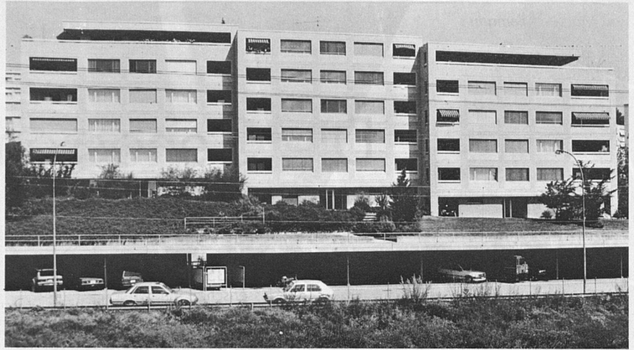
31 Wohnungen an der rue des Troncs in Neuchâtel («Mon Logis» seit 1. Juli 1990).
