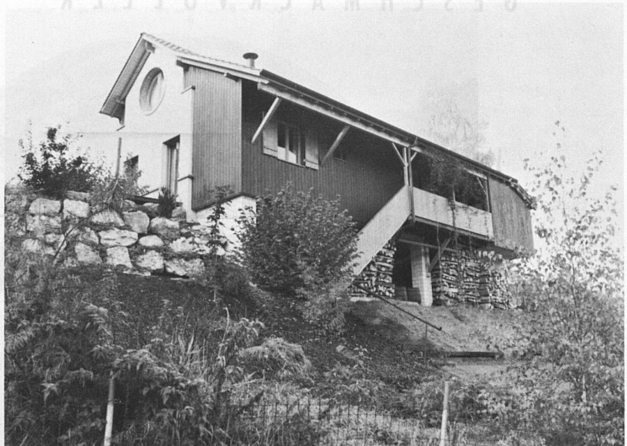
Nordseite mit Laube und Treppenabgang zum Untergeschoss
