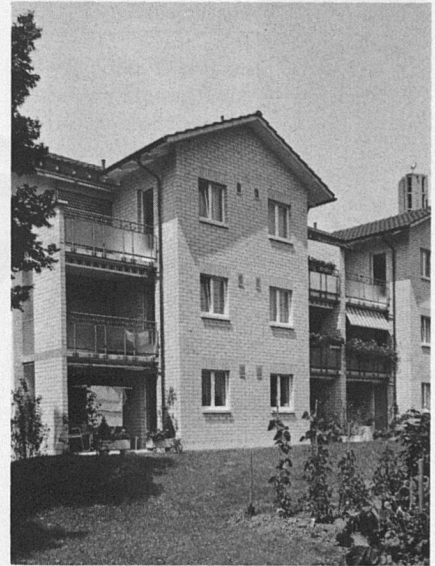
Im Bild sind die angebauten neuen Küchen und Balkone der 2-Zimmer-Wohnungen zu sehen: Eine Investition, die – bei Mietzinsaufschlägen zwischen Fr. 200.– und Fr. 250.– – mehr als gerechtfertigt ist.
