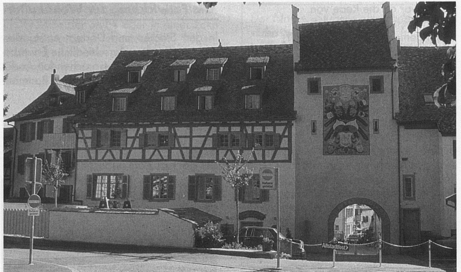
Oberhof in Stein am Rhein. Nach der Sanierung können auch Behinderte in diesem mittelalterlichen Gebäude wohnen. 13 der 14 Wohnungen und die Ladenräume im Erdgeschoss sind rollstuhlgängig.
