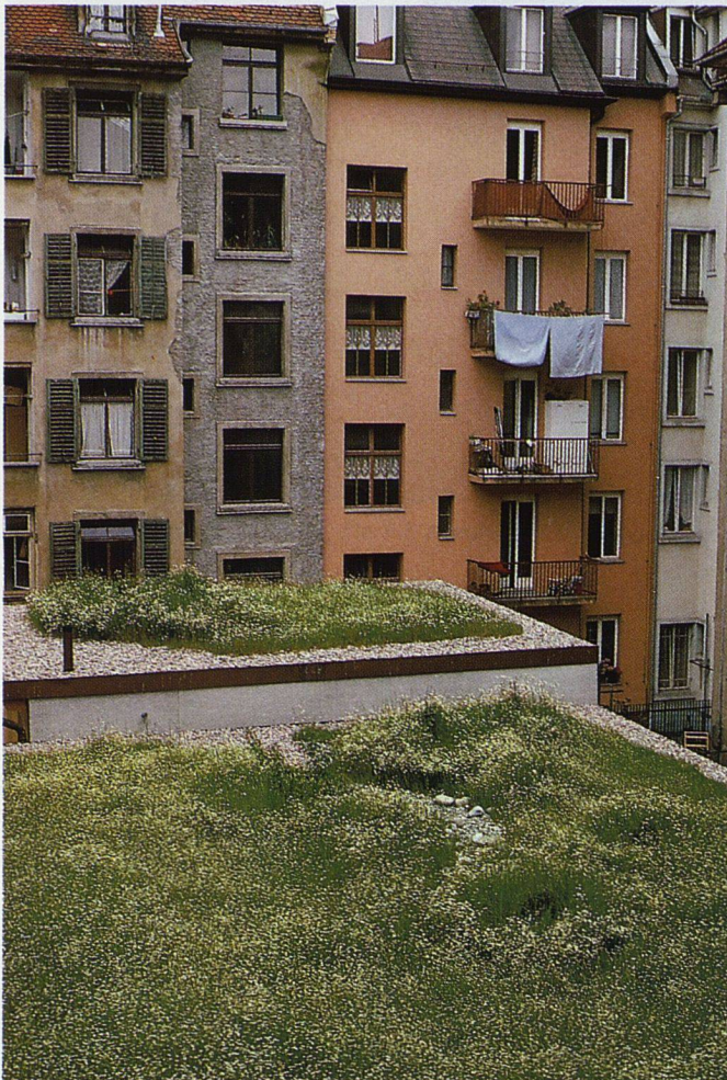
Diese Extensivbegrünung auf einem Lagergebäude bringt nebst ökologischen Vorteilen eine wohlthuende Belebung des Hinterhofes.
