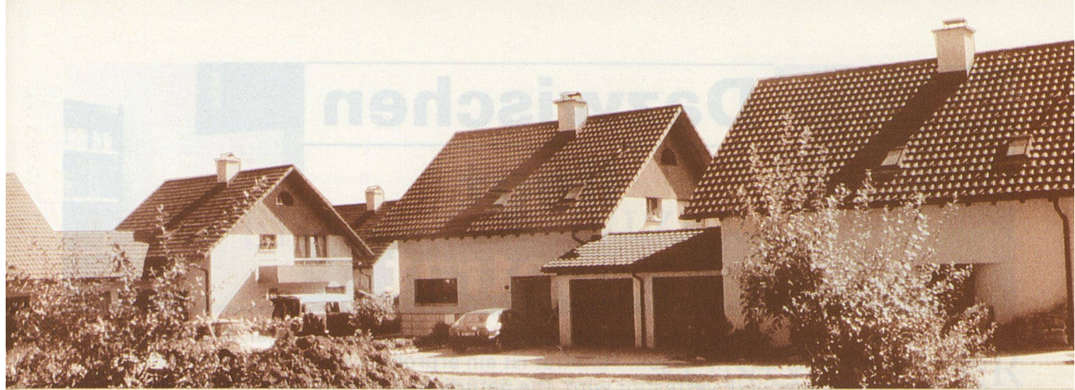
Diese Mehrfamilienhausssiedlung in Steinen wird mit geothermischer Wärme beheizt.
