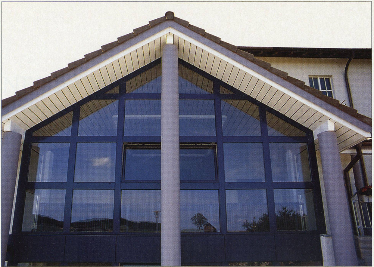
Eine Hausfront aus Glas: Elegant in der Wirkung, hell als Arbeitsplatz – die Reinigung jedoch dürfte schwierig sein.
