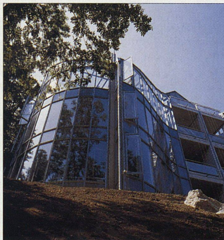
Verglaste Anbauten wirken isolierend.
