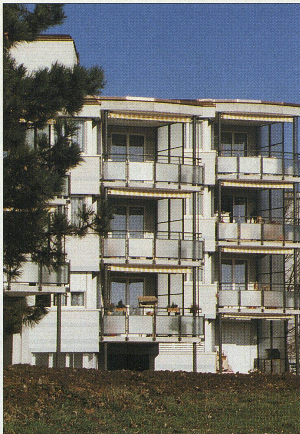
Neue Aussichtsbalkone vor den Wohnküchen.
