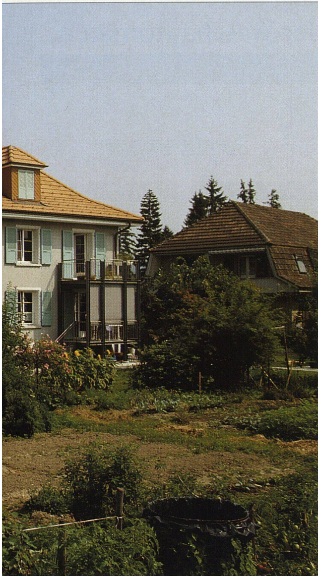
Familienhäuser nach der Sanierung
