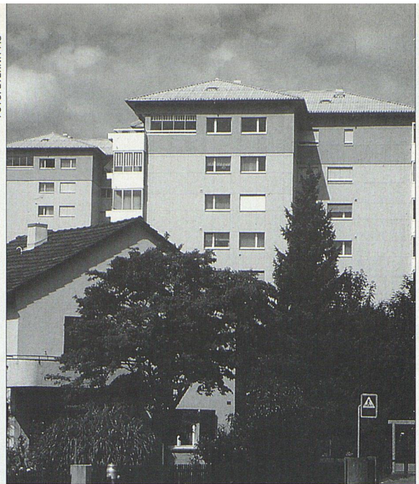
Neu: Giebel- statt Flachdächer ergeben mehr Wohnraum.
