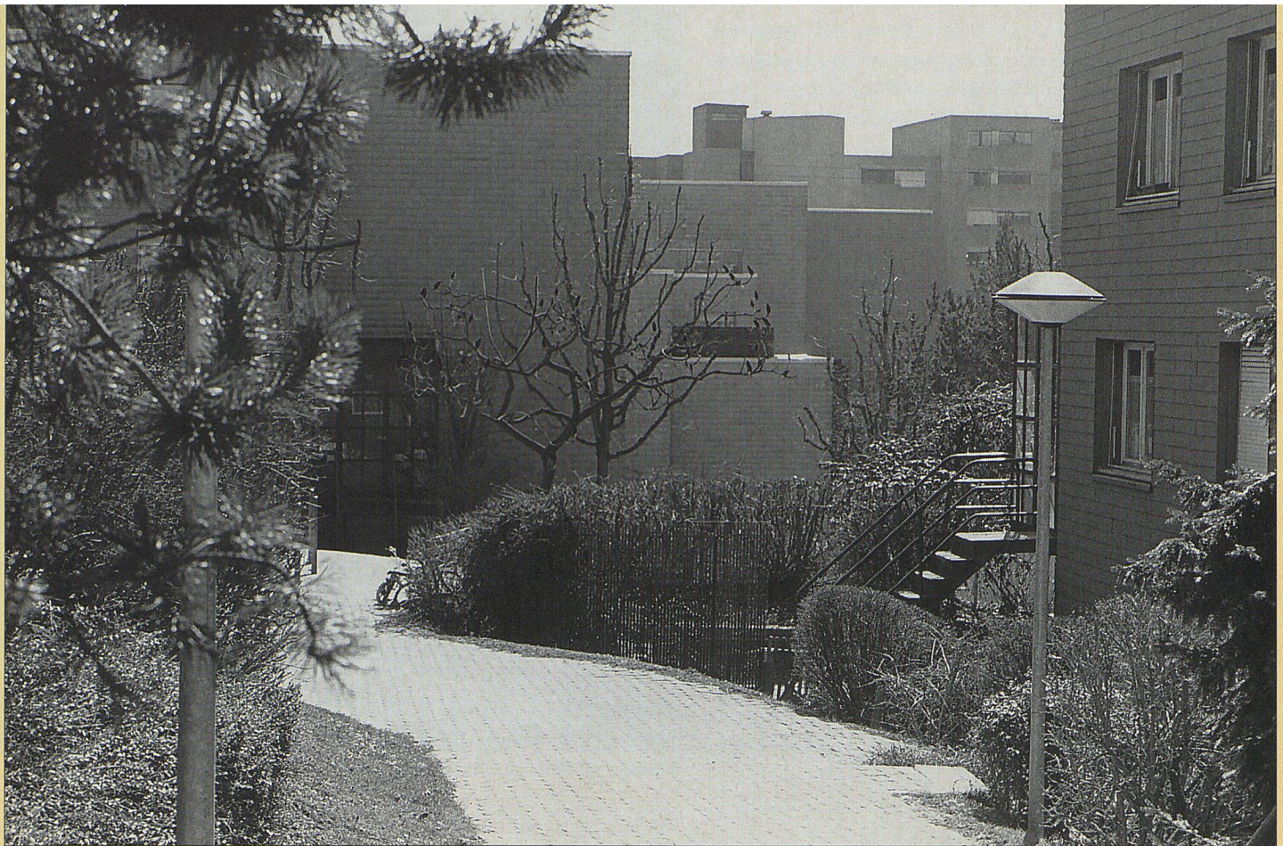
L'organisation variée des volumes construits a valu au quartier des Boveresses le titre de «casbah».
