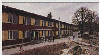
«Im Niederholzboden» Riehen, Genossenschaft Wohnstadt Basel, Metron Architekten
