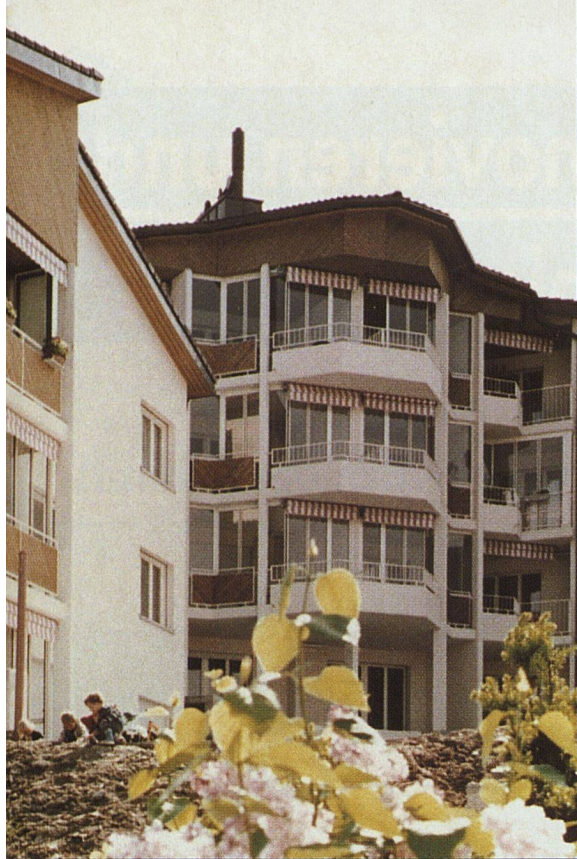
wertet die Fassade auf und spart Energie.
