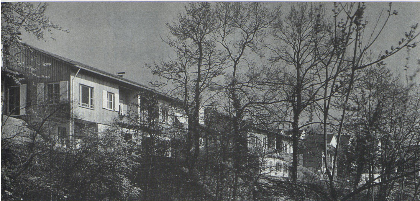
Siedlung Jakobsberg Basel, erste Etappe: Hermann Baur versuchte, die gewachsene topografische Struktur zu erhalten.
