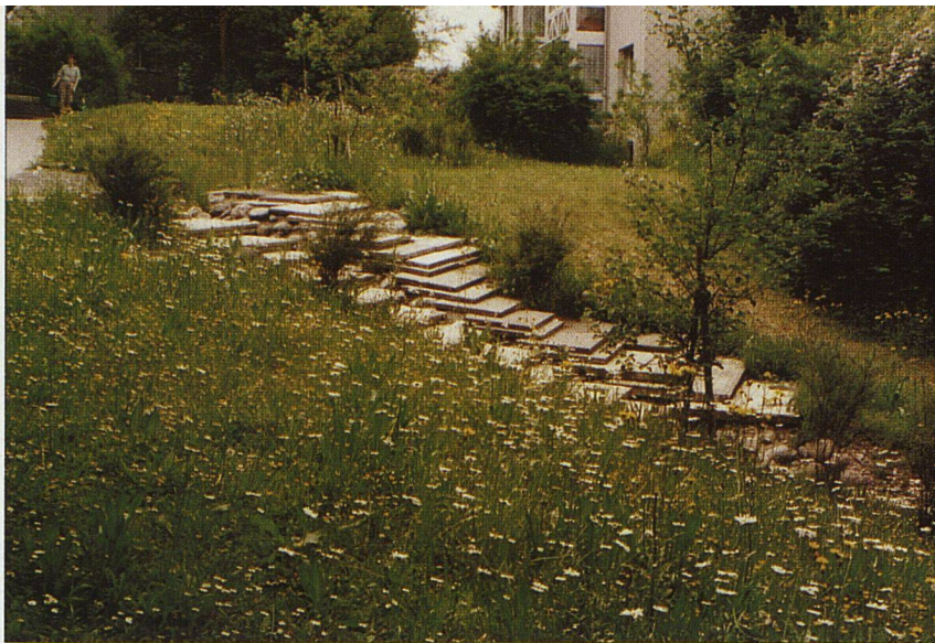
Beim aufgedeckten Bach wurden ausrangierte Betonelemente zur Neugestaltung eingesetzt.
