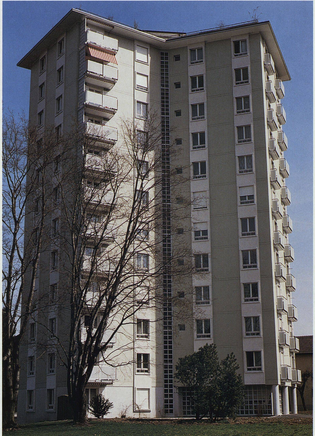
Hochhaus Gutstrasse 150, Zürich
