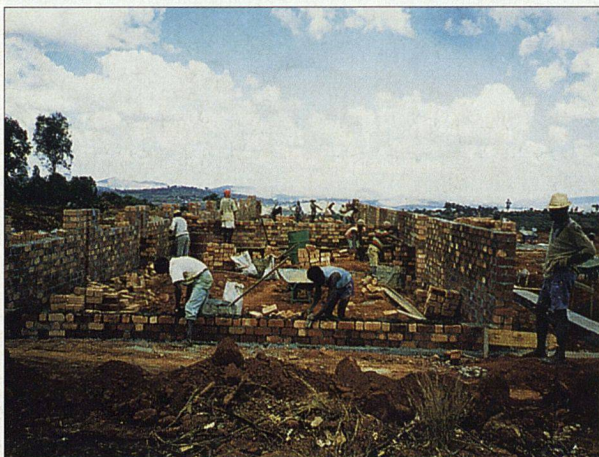
Alle vier Projekte umfassen auch den Bau von Infrastrukturanlagen: Bau eines Schulhauses und einer Kinderkrippe in Madagaskar.
