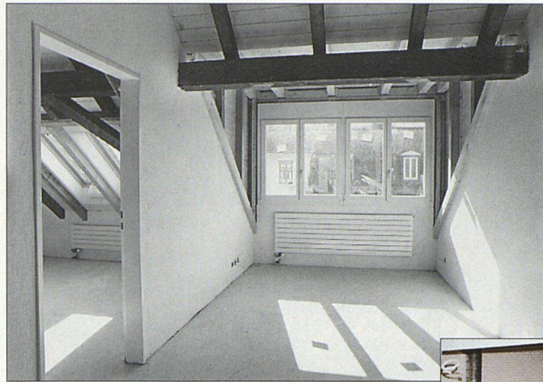
Mit dem Ausbau der Dachgeschosse entstanden helle Dachwohnungen mit grosszügigen, offenen Küchen.
