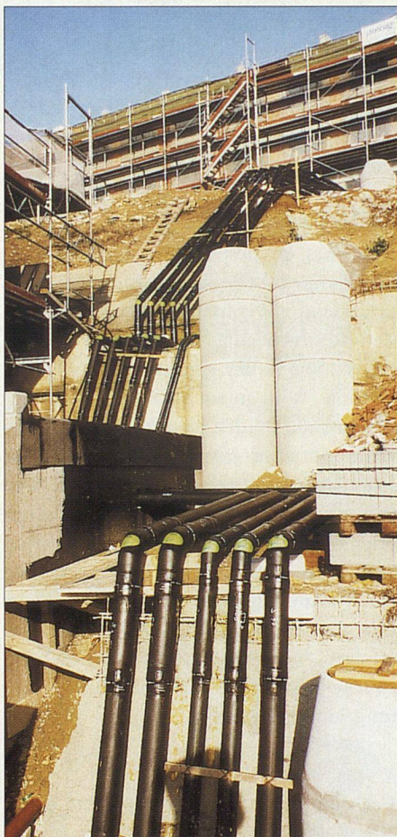
Haus-zu-Haus-Verbindungsleitungen, vorisoliert, für Heiz- und Sanitärwasser in einer Hangsiedlung bei Ebikon/LU.
