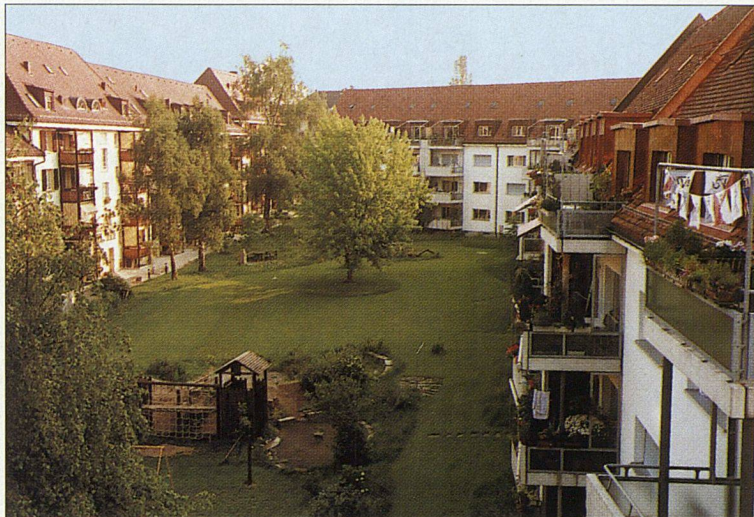
Die BG Freiblick in Zürich hat alle ihre 500 Wohnungen nach dem neuen System berechnen lassen. Im Bild der Innenhof der Siedlung Illanzhof.
