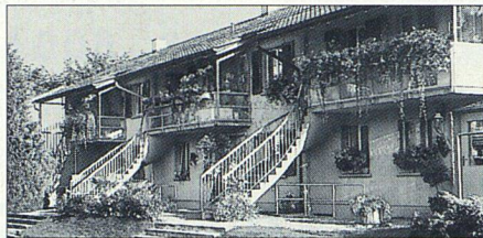
«Stägehüsl» mit sanierten und leicht vergrösserten Balkonen
