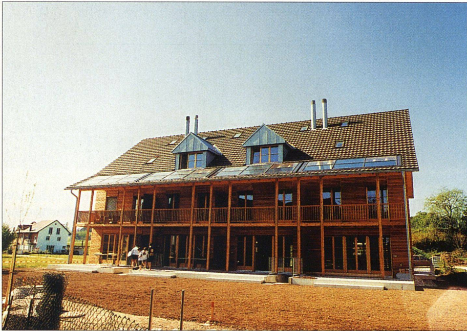
Reihen-Einfamilienhaussiedlung mit je einer Kompakt-Solaranlage pro Partie. Die Mehrinvestitionen betragen rund 8000 Franken pro Wohnung.
