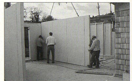
... ist der Holz-Rohbau bereits aufgerichtet.
