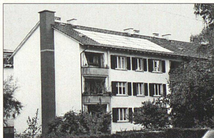
Solare Warmwasservorwärmung an der Rauracherstrasse 7-17 in Riehen
