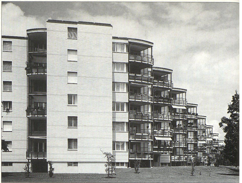
Die grosszügigen Balkonanbauten nach der Renovation
