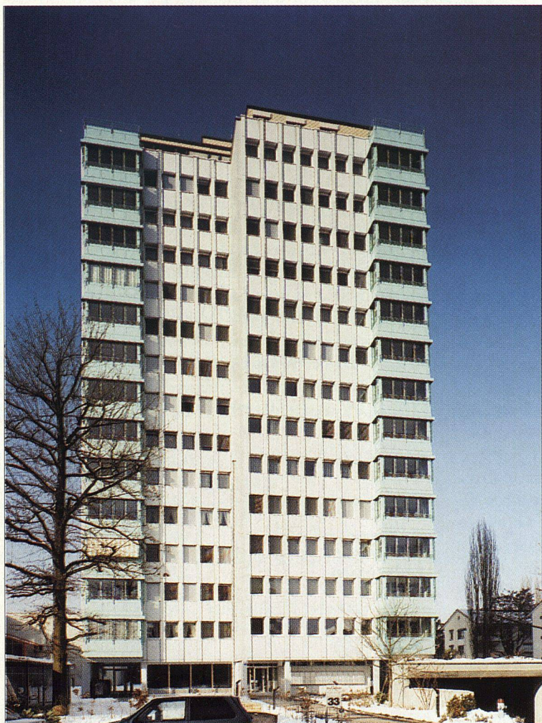
Die neue Materialisierung und die Balkone verändern die Fassade markant.
