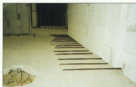
Die Armierungseisen für den Überbeton wurden direkt in die bestehenden Ytong-Wände versenkt. Die Betondecken waren bis zu 10 cm dünn.
